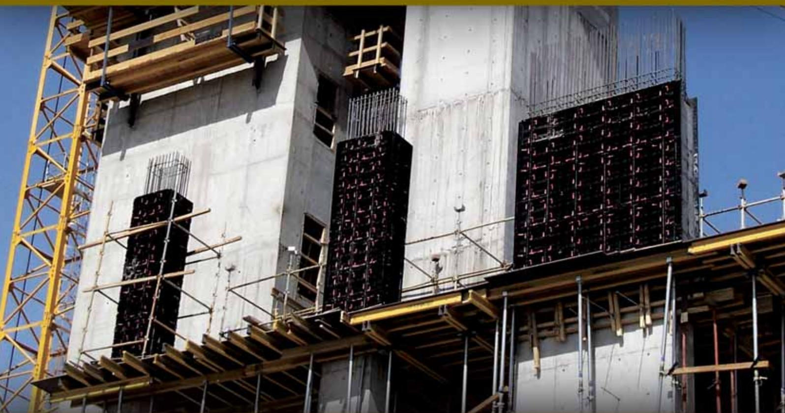
система модульной пластиковой опалубки
